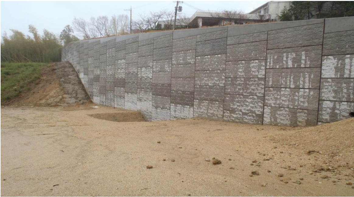
市道高瀬天野線整備工事（その1） 竣工写真（平成 26 年 4 月撮影）
