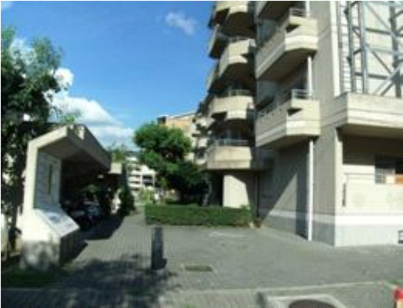
市営桜ヶ丘住宅
