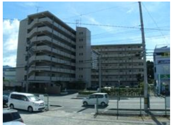
市営三日市西住宅
