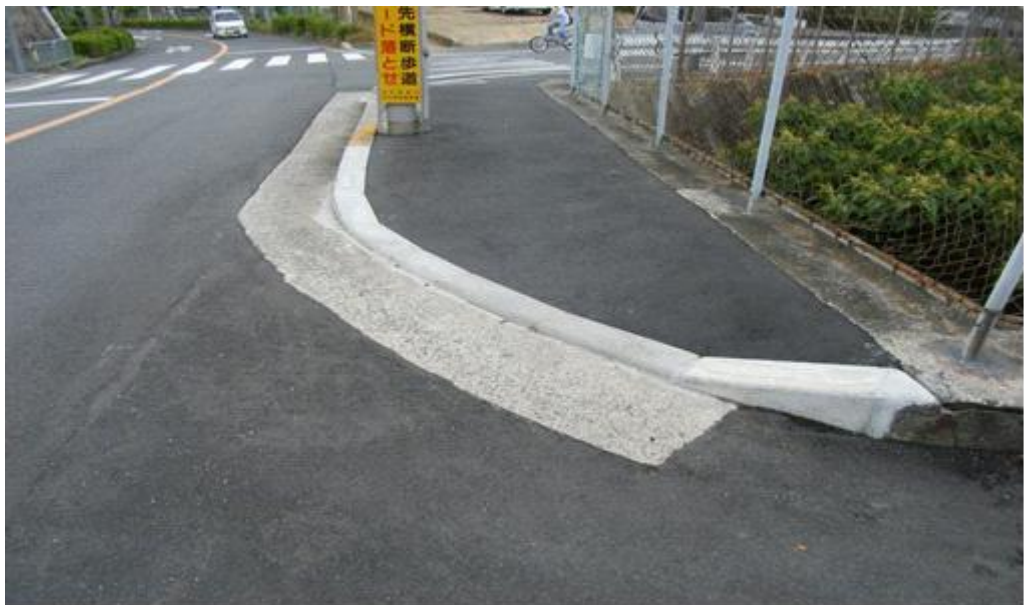
歩道段差改善工事
