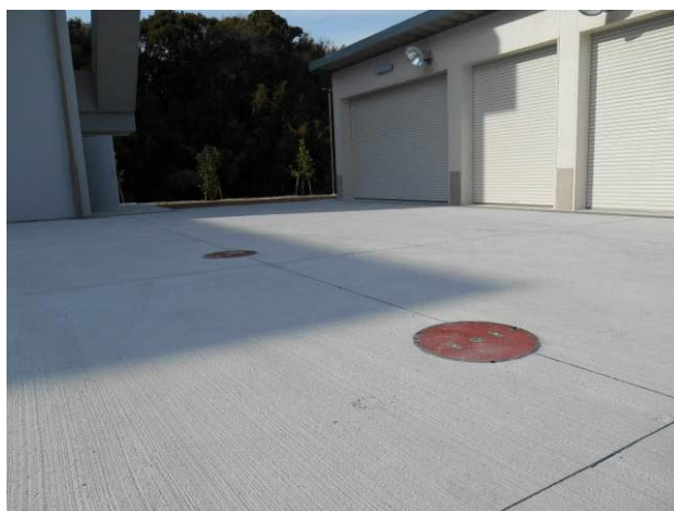
新設した耐震性防火水槽（４０立米）
