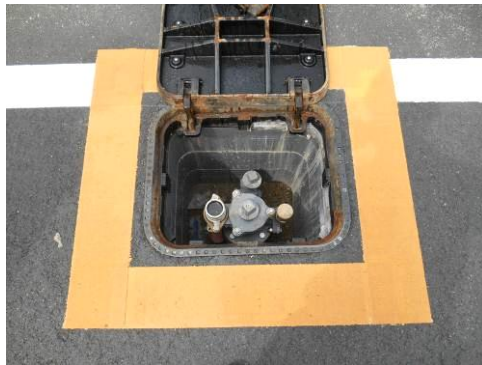
消火栓本体更新
