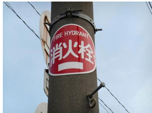
消火栓標識板
