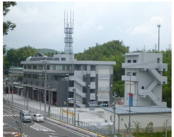
河内長野市消防本部新庁舎（全景）
