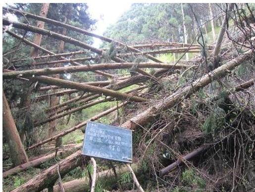
【倒木処理】 施工前
