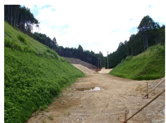
日野区間工事状況
