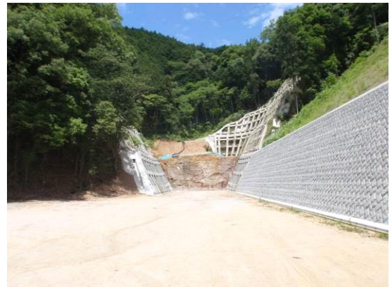
加賀田区間工事状況
