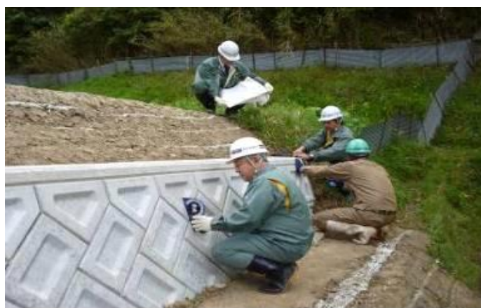
（工事完了検査風景）
