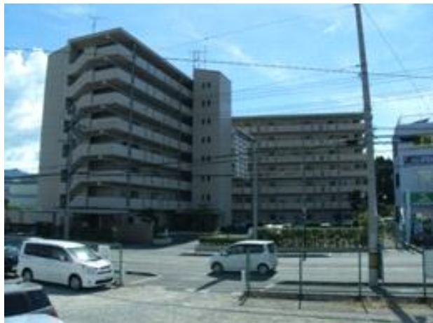
市営三日市西住宅
