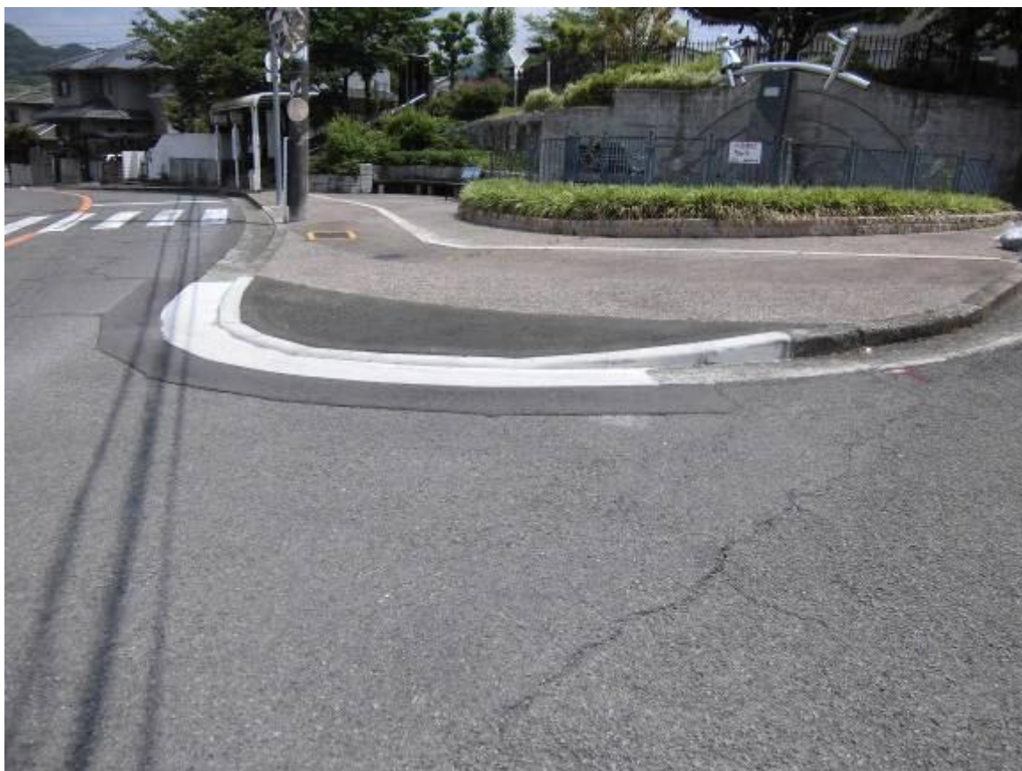
歩道段差改善工事
