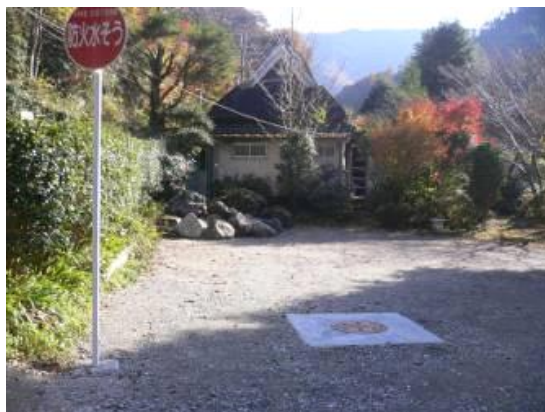
新設した耐震性防火水槽（４０立米）
