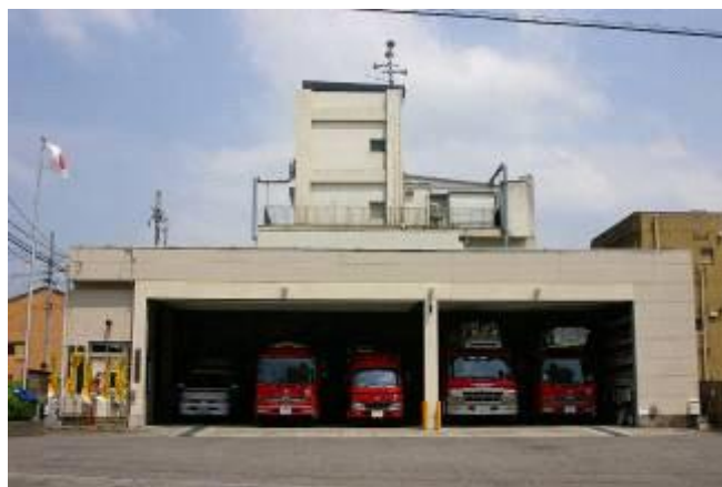
昭和４０年に建築された消防署本署
