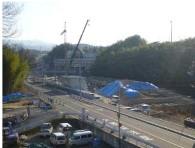
消防防災拠点施設建設現場（全景）
