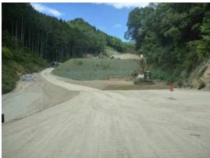
加賀田区間工事状況
