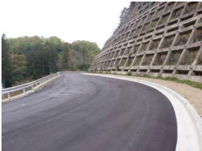
府道加賀田片添線取付道路部
