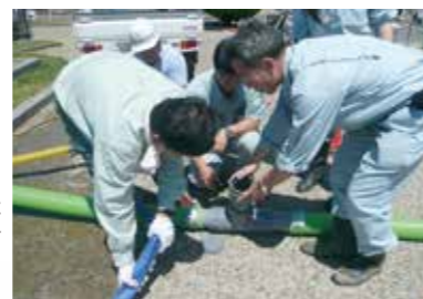
サイホンをを使った簡易緊急放流研修の様子(寺ヶ池)
